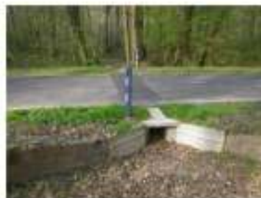
Exemple de passage sous voirie – Biotope 2015
